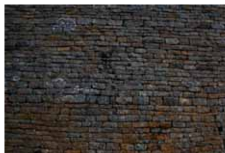
小さいブロックがきれいに積まれています。
