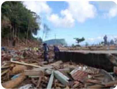
▲津波被害の現場
