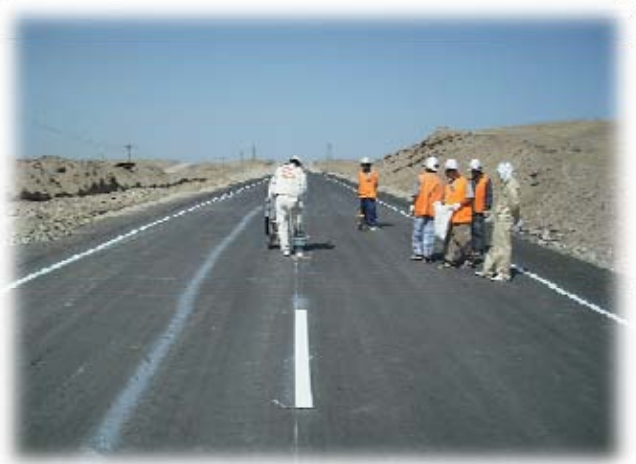
白線を引いている日本人技師とタジク人技師
