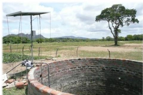
井戸と太陽電池です。井戸水を太陽光から作った電気でモーターを回して水をくみ上げ、畑の畝に細かい穴を開けたホースを張り巡らして畑にジワジワと水分を補給します。これで、乾季でも野菜を育てることができます。
