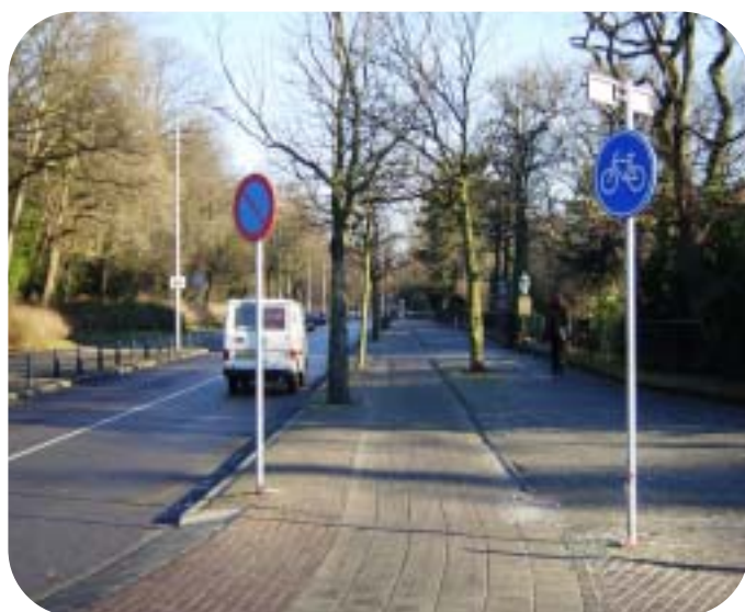
車道と自転車専用道と歩道がはっきり分けられています。
