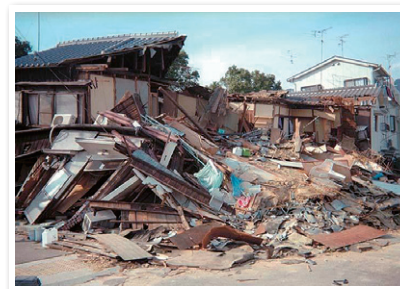
Grande Terremoto Hanshin-Awaji
